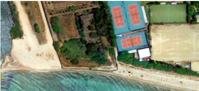
IMPIANTI DI MARINA RESIDENCE - STELLA DI MARE 1 E 2 - VIA VULTURNO
