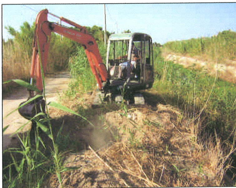
Figura 2. Fase di esecuzione pozzetti geognostici sull'argine sinistro del Rio Foxi
