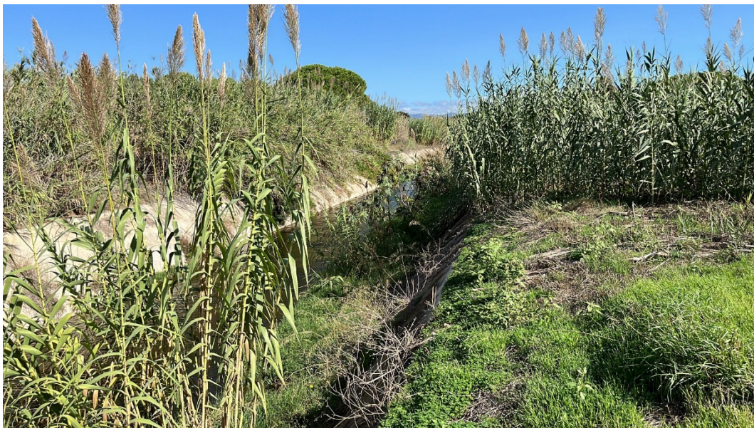
Fondo e sponde rivestiti in cls
