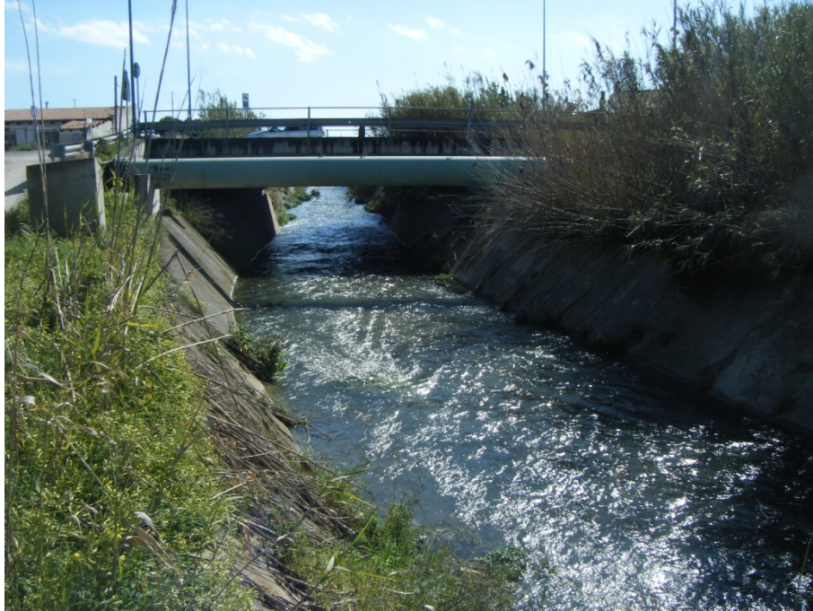
Vista da monte del ponte sulla SP 17
