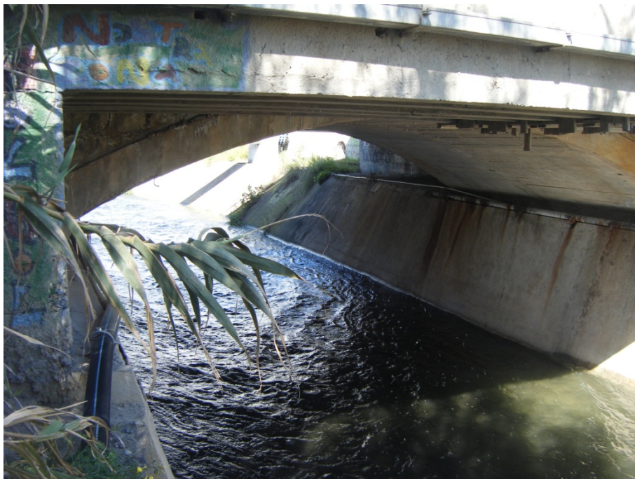
Dettaglio vista da monte del ponte sulla SP 17
