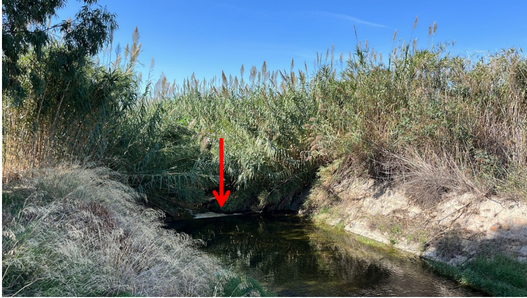
Tratto focivo: fondo e sponde rivestiti in cls, con soglia al fondo
