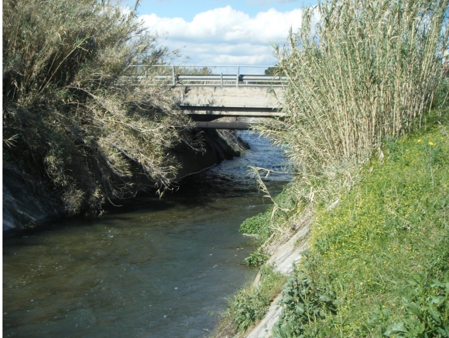
Vista da valle del ponte sulla SP 17
