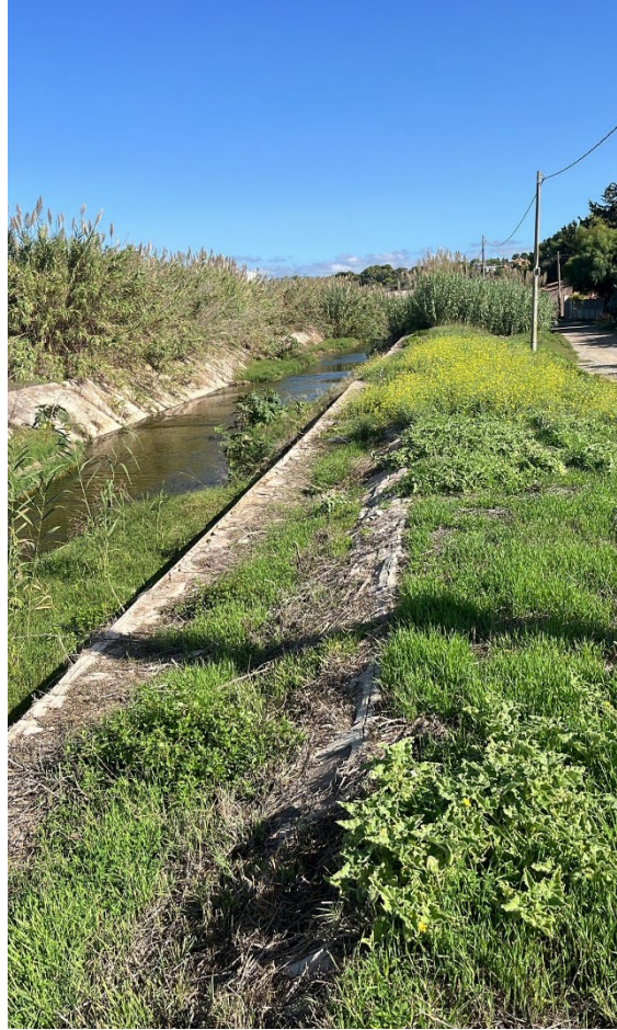
Fondo e sponde rivestiti in cls; di lato, la strada sterrata
