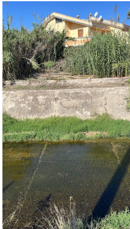
Dettaglio fondo e sponda rivestiti in cls
