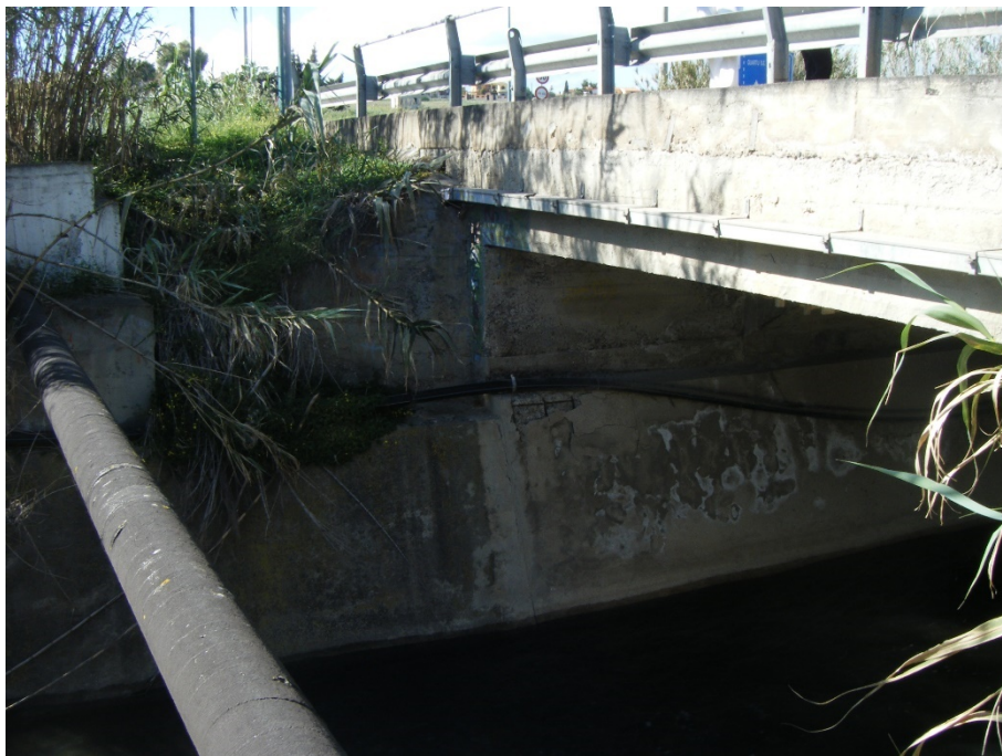
Dettaglio vista da valle del ponte sulla SP 17
